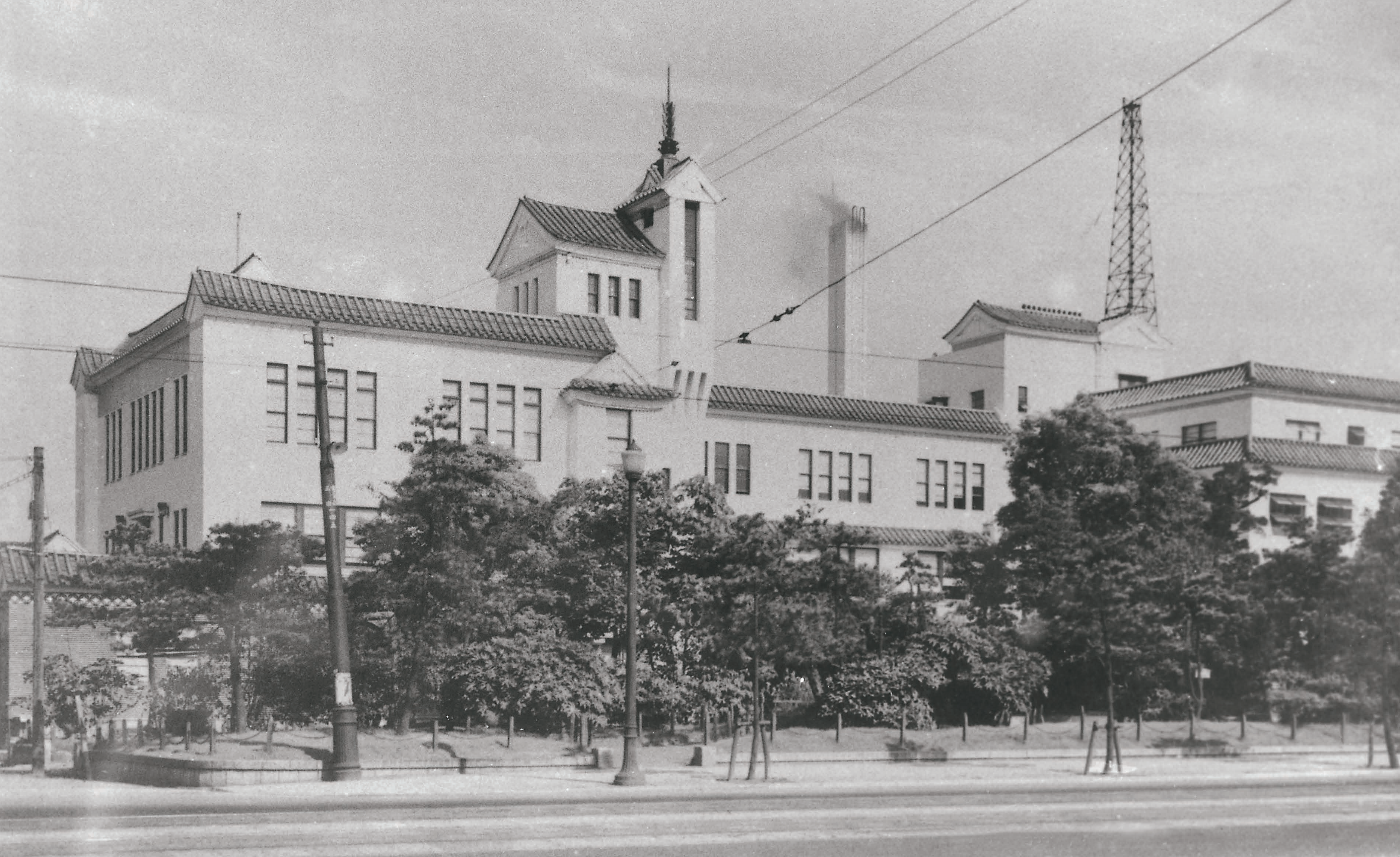
日比谷通りから見た女子会館全景
